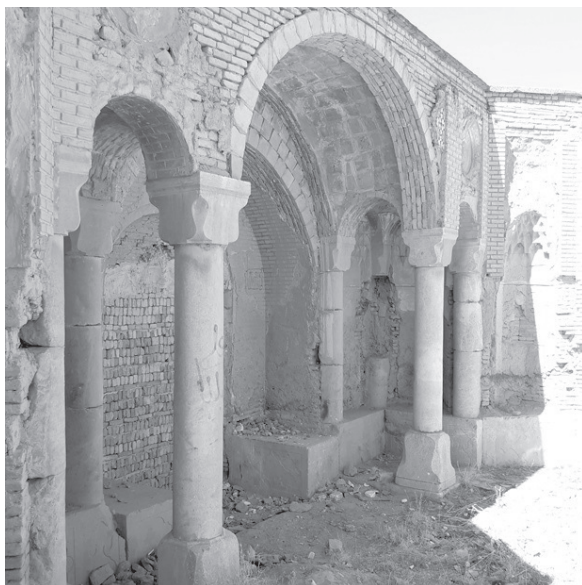
تصویر شماره ۶. آجرچینی قوس‌های سردر ورودی (نگارنده)
