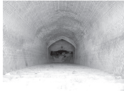
تصویر شماره ۱. آب انبار پیش از تخریب (نگارنده)
