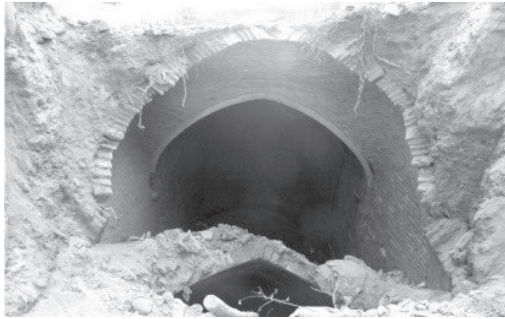
تصویر شماره ۲. آب انبار پس از تخریب (نگارنده)
