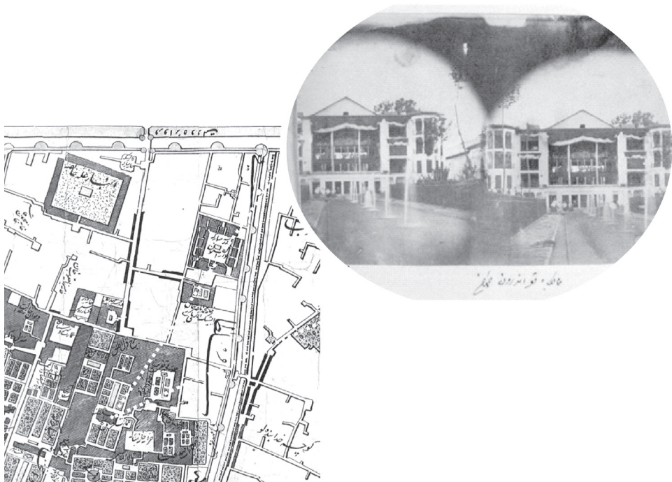
تصویر شماره ۹. نمای شمالی خوابگاه اندرون یا عمارتی که حاجب‌الدوله در حیاط فروغ‌السلطنه ساخته بود (شیرازیان، ۱۳۹۷: ۱۶). تصویر سمت راست بالا از آلبوم‌خانه کاخ گلستان (سمسار و سراییان، ۱۳۸۲: ۲۴۴)
