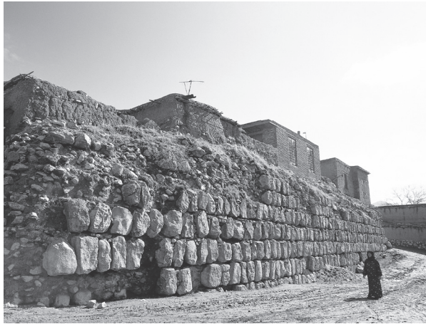
تصویر ۳: دیوار قلعه سرماج و سنگهای تراش‌خورده نوع ساسانی که در بنای آن بکار رفته است (منبع: آرشیو پایگاه میراث جهانی بیستون)
